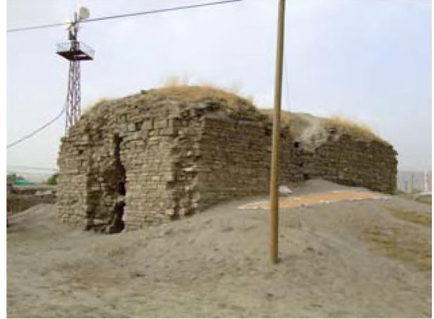
Resim 6: Kırköy Kilise güneybatı genel görünümü
