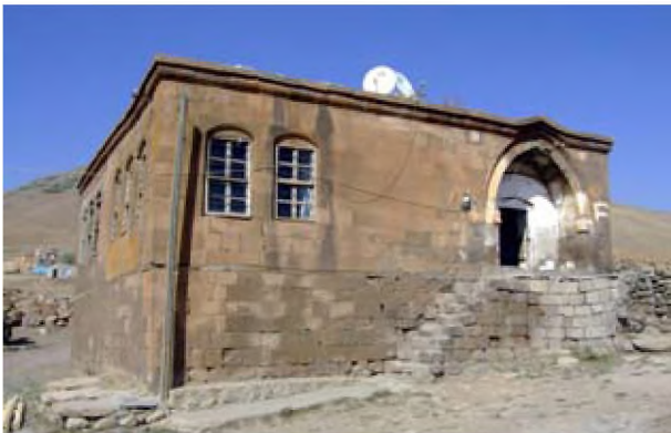
Resim 3: Abdalbavezit Köyü Servet Anslan Evi dış görünüşü
