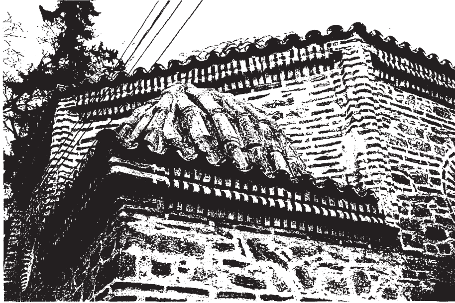
Resim 16: Halime Hatun Darü'l Hadisi, derhane odası, kaskanak
