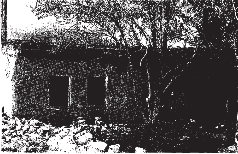
Resim 2: Karaman'da 28 no lu evin güneydoğu cephesi
