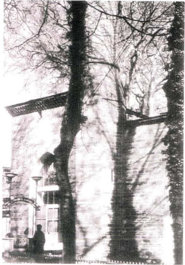
Resim 3: Ishak Paşa Camisi, son cemaat yeri batı cephesi ve minare kaidesi
