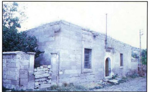
Resim 6: Gesi Surp Asvazdzin Kilisesi, güney cephe
