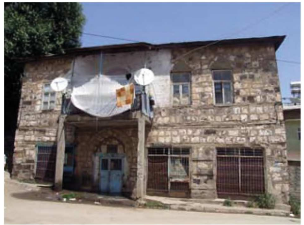
Resim 12: Tahsin Saraç Evi güney cephe
