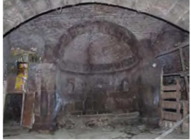
Resim 15: Yukarı Yongalı Çengilli Kilisesi I No.lu Kuzeydoğu Yapısı apsisi
