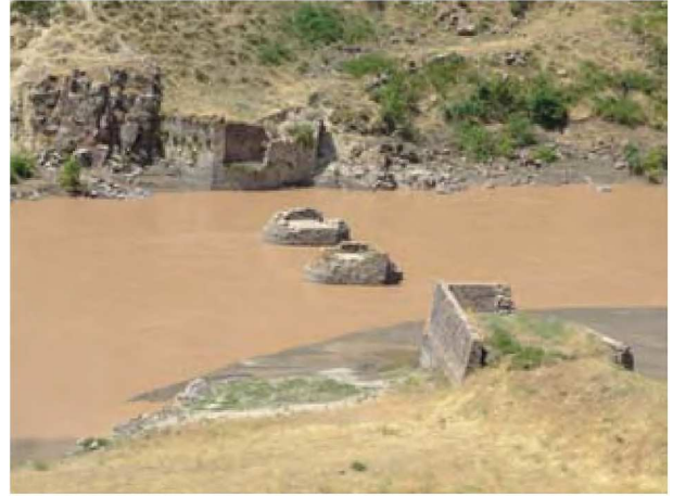
Resim 9: Balotu Köyü Seyda Köprüsü
